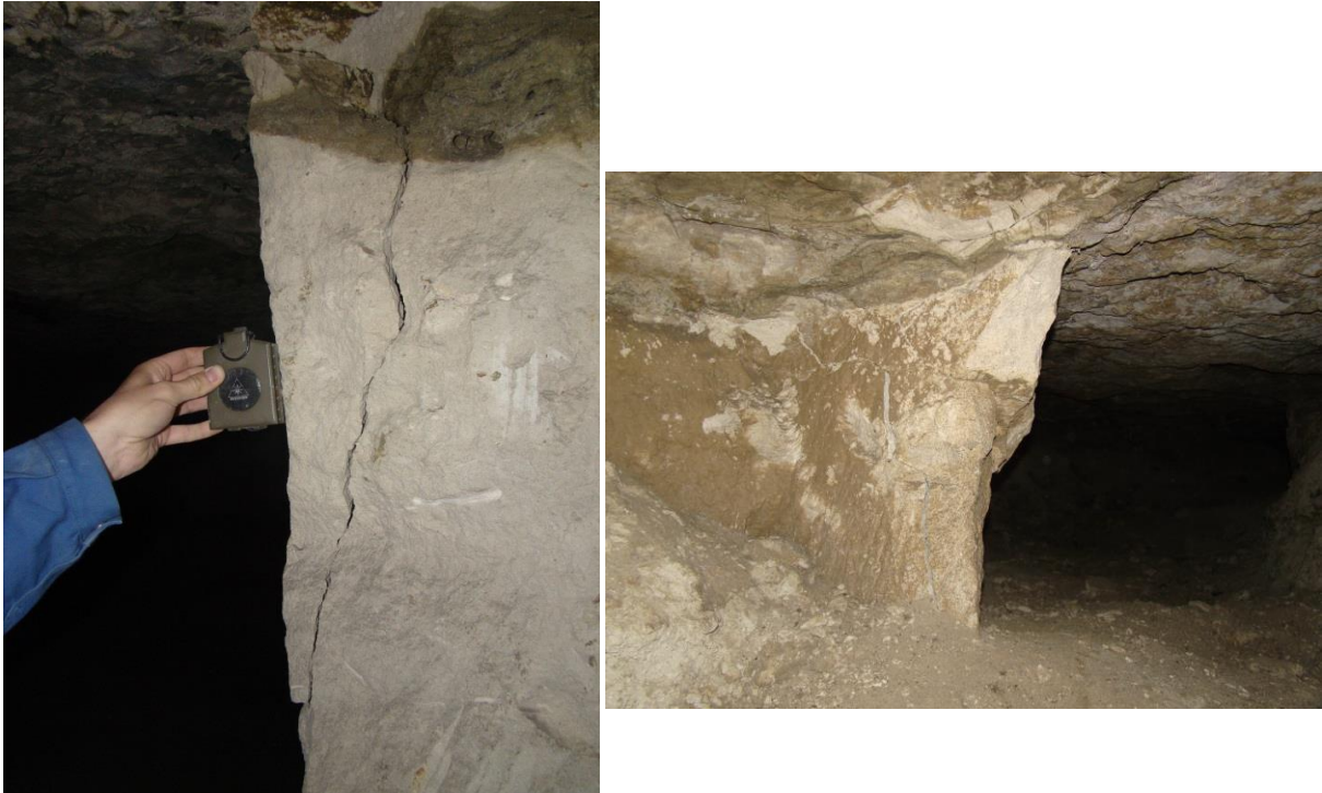
Illustration 9 : Ecaillage des angles dans certains secteurs
