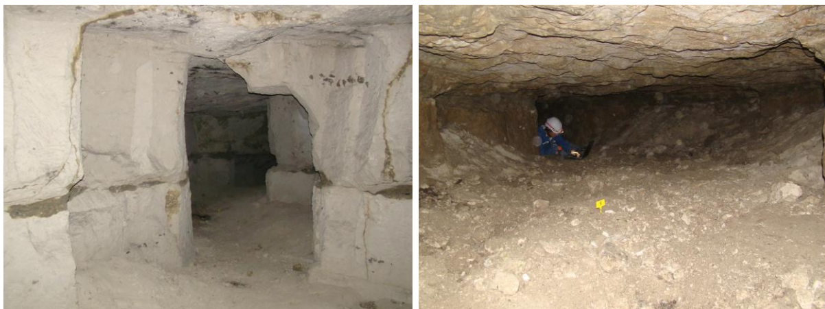
Illustration 7 : Vue de la carrière de Bellavilliers : à gauche, géométrie caractéristique d'une carrière souterraine exploitée pour la pierre de taille et à droite, galerie remblayée à plus de 50 % (galerie filante, orientée vers le sud)
