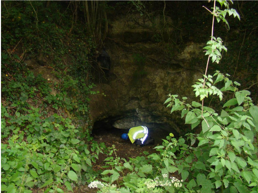
Illustration 6 : Accès par cavage à la carrière souterraine, en grande partie remblayé (déblayé par la propriétaire actuelle)
